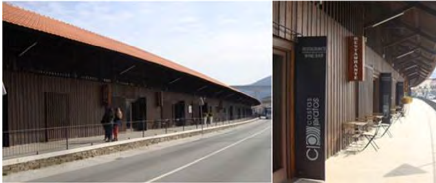
Figura 8 (a) – Cais coberto de Peso da Régua
