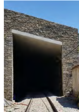
Figura 9 (b) – Integração Paisagística –Linha do Douro (construção de um falso túnel)
