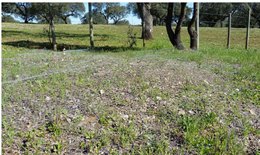
Fig. 35 – Colocação de rede sobre os taludes da EN4, com o objetivo de impedir a sua colonização por coelhos.
