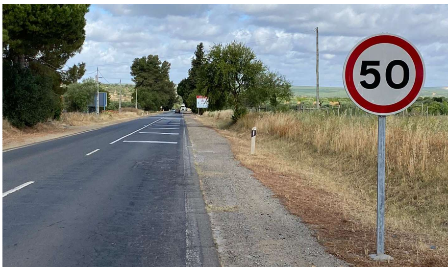
Fig. 33 – Sinalização de limite de velocidade na EN260, com bandas cromáticas e painel com sinalização de alerta relativa ao lince-ibérico (ao fundo).
