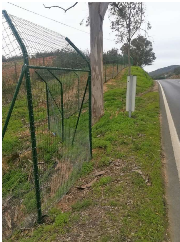
Fig. 32 – Vedação para lincos, instalada na EN122.
