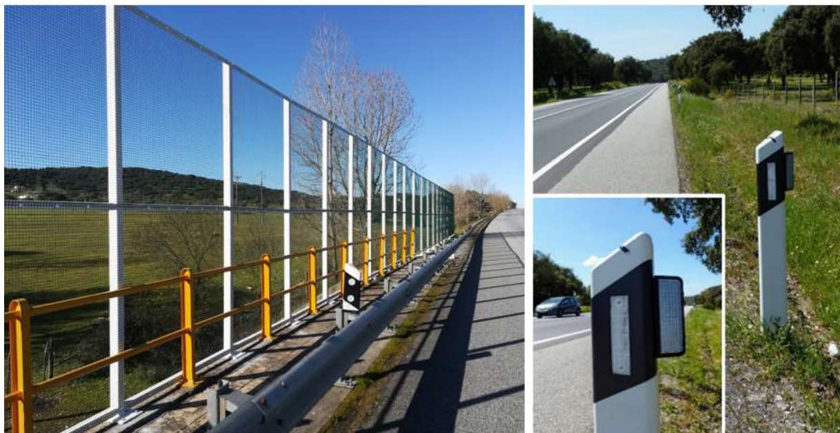
Fig. 36 – Barreiras para elevar e encaminhar o voo de corujas (à esquerda) e refletores específicos para refletir a luz dos faróis para a envolvente da via e alertar os animais de forma mais eficiente (à direita).
