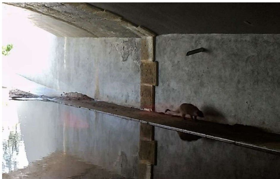
Fig. 21 – Fotografia de um sacarrabos atravessando uma PH inundada, na EN114, através de um passadiço seco (capturada por câmara de disparo automático, no âmbito do Projeto LIFE LINES).
