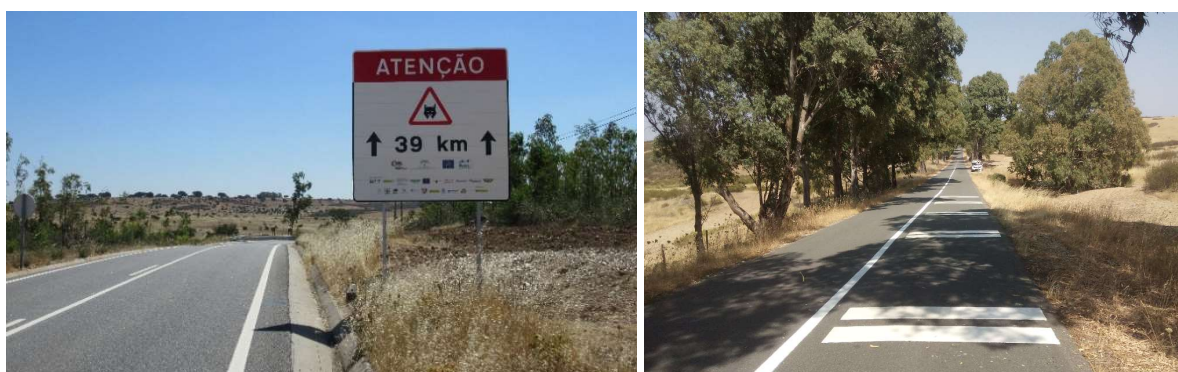
Fig. 29 – Sinalização avisadora de perigo, específica do lince-ibérico (esquerda) e bandas cromáticas redutoras de velocidade (direita) instaladas na EN122.
