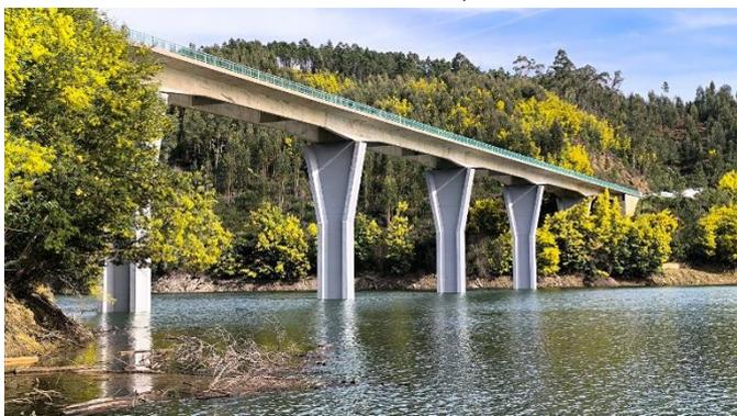
Em todos os pilares, P1 a P6, procedeu-se à remoção de varões salientes, à reparação superficial do betão e à pintura das superfícies emersas, de forma a reforçar a proteção e aumentar a durabilidade global da estrutura. Estas intervenções permitiram colmatar irregularidades, proteger contra a erosão e o ataque químico da água da albufeira e prolongar a vida útil da ponte.
