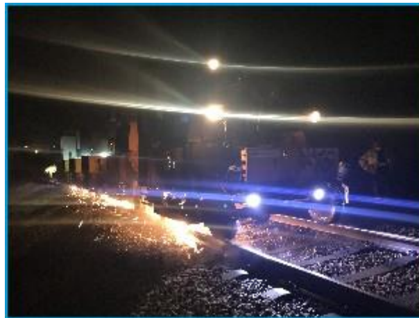
Figura 19. Esmerilagem de carris (fonte: www.fergrupo.pt ).
