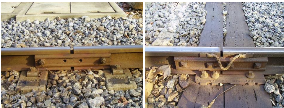
Figura 13. Juntas em carril de barra curta geradora de ruído com carácter impulsivo.
