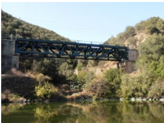
Pontes Metálicas Linha da Beira Baixa
