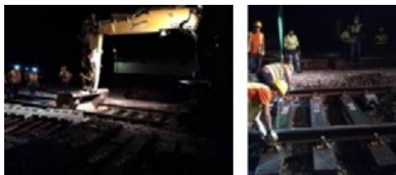
Substituição de travessas de madeira pelas travessas Eco Rail.
