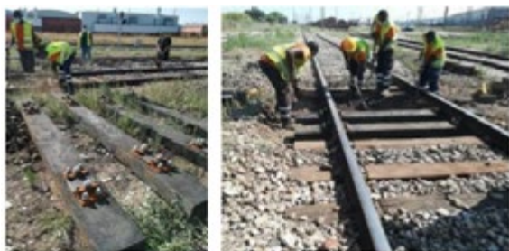
Processo de instalação das travessas, numa linha de acesso à triagem, no Entroncamento
