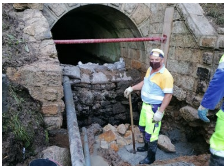
Manutenção de Obra de Arte
